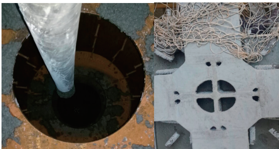
图9 亚投行C60自密实高抛施工现场照片及箱型柱
