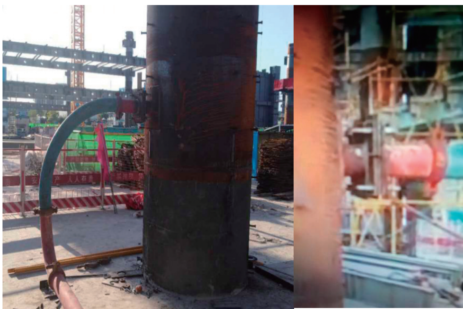
图8 亚投行C60自密实顶升施工现场照片
