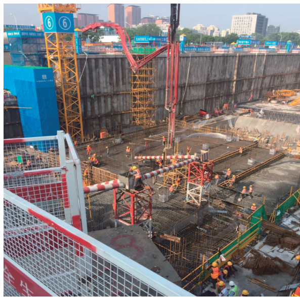
亚投行大体积混凝土工程施工图
