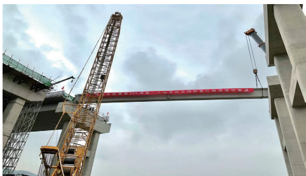
图为2022年6月9日 国道109新线军庄主线桥首片预制箱梁吊装现场
