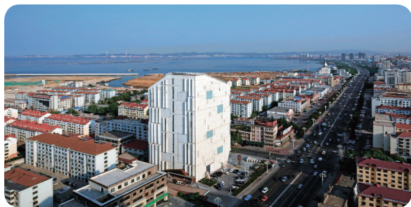
应用预制混凝土外墙挂板的威海名座项目 北京榆构/供图
