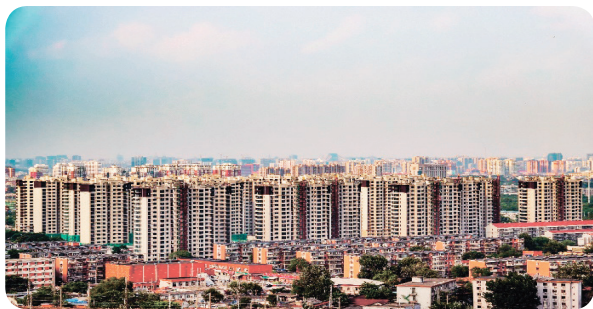
北京市丰台区榆树庄回迁房（装配式住宅）项目
