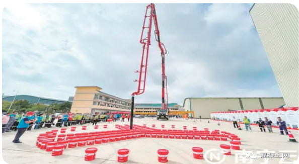
参赛选手遥控臂长为62米的泵车，模拟施工现场输送混凝土浇筑墙体。记者 黄红锦 摄
