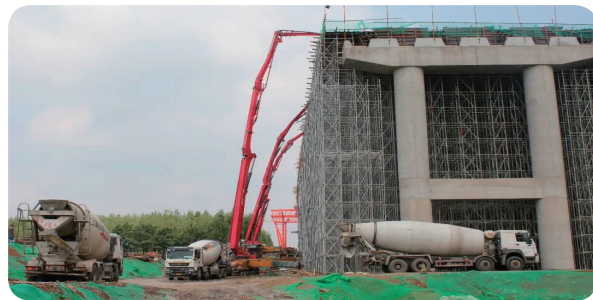
中铁二局集团有限公司京雄高速(北京段) 二工区项目筏板浇筑
