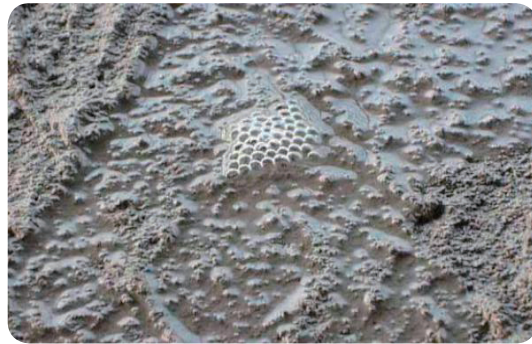
图2 混凝土冒泡现象、混凝土整体膨胀现象
