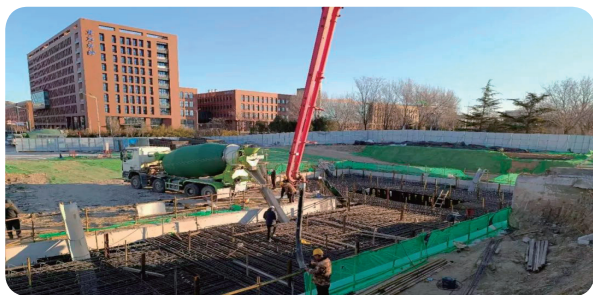
北京经济开发区文昌大道跨凉水河桥工程供应混凝土
