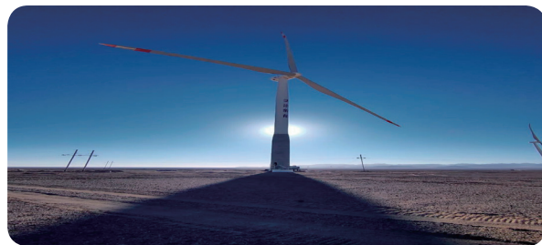
高强公司青海冷湖镇天润 200 (MW) 混塔预制构件项目
