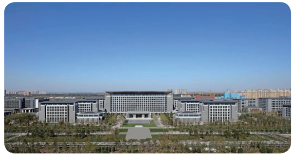
北京行政副中心市政府办公楼-外墙挂板工程
