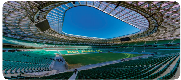
北京工人体育场-预制看台工程
