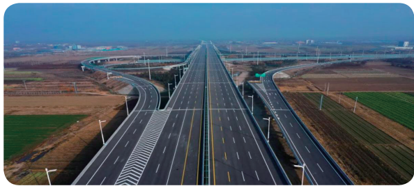
京雄高速-预制桥梁工程
