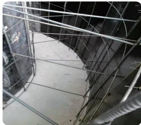
图4-4 容器内部布筋图
