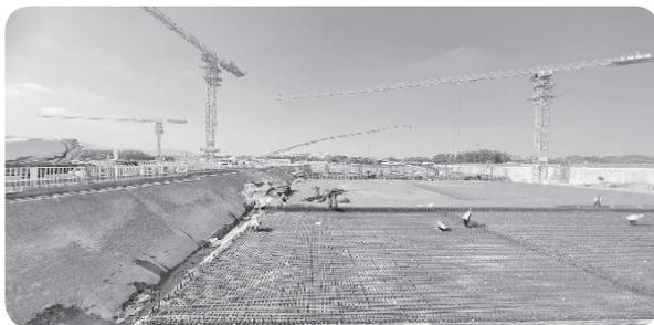
根据温泉水厂的用途及特点，部分混凝土需长期在水中浸泡，因此西北旺站技术团队对混凝土耐久性能十分重视。因项目选址土质含硫酸盐成分，所有 CFG 桩基部位需使用抗硫酸盐侵蚀混凝土，技术团队结合以往供应稻香湖水厂一期、二期工程的经验，根据温泉水厂工程实际情况需要，在抗硫酸盐侵蚀混凝土配制过程中，选用合适的掺合料和优质骨料，降低水灰比，提高粉煤灰和矿渣粉用量，减少硫酸侵蚀反应的发生，有效提升混凝土耐久性能。
