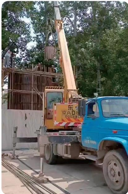
图4-8 吊车及吊斗现场作业
