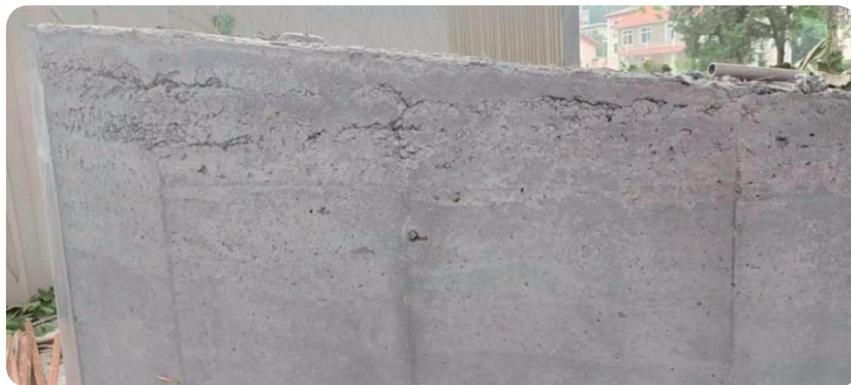
图4-10 圆柱截锥容器斜坡部分未充分振捣引起混凝土蜂窝麻面现象
