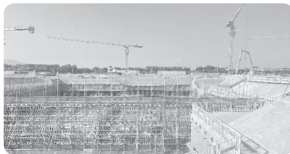
项目底板部位厚度高、方量大，墙体部位超 9 米，故需使用大体积抗渗混凝土和超高超宽抗裂混凝土，由于这两种混凝土具有体积庞大、结构厚实等特点，且施工方要求连续浇筑，因此在混凝土配比设计中，“抗裂”成为浇筑该部位的关注重点，其配比和养护均有别于一般寻常混凝土结构要求，需严格控制坍落度在 180 至 200 之间，优选粗细骨料级配，同时采用膨胀
