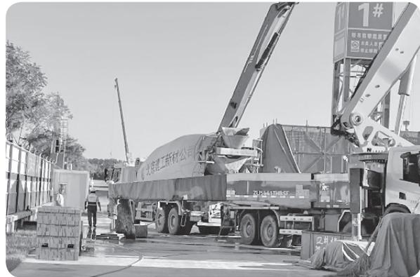
9月30日，通州分公司顺利完成该项目底板浇筑，累计浇筑混凝土9862立方米。
