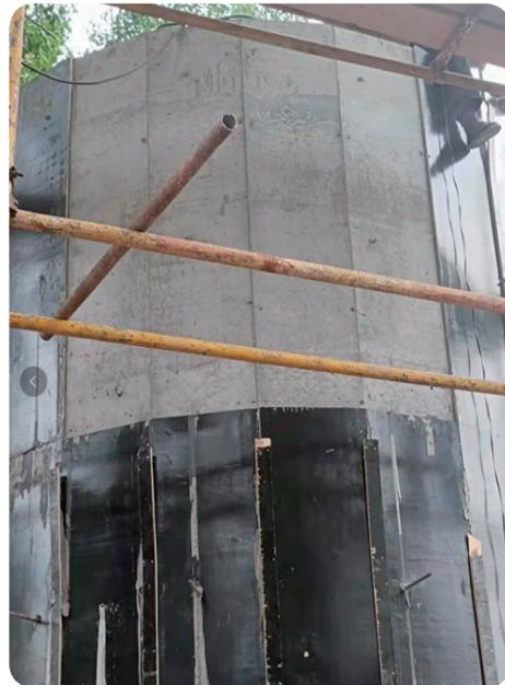
图4-9 拆除外模过程中的照片
