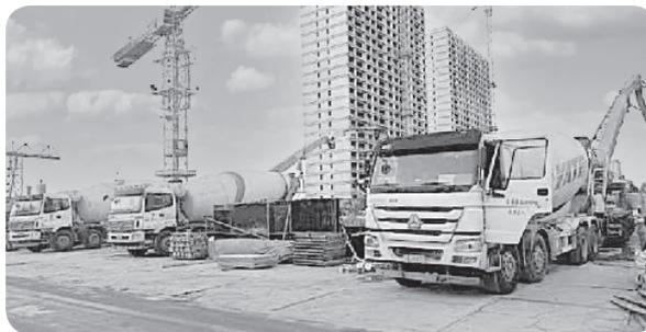
工地现场，罐车整齐排列，工人绑扎钢筋，三台汽车泵同时向模板内浇筑。该项目有五块底板，其中四块使用跳仓法进行浇筑，短期集中浇筑量大，金盏站统筹好地铁13号线等其它工程，错峰生产，仅底板供应期间发出车辆700余次，避免压车、断车，有效保障浇筑连续性，实现23小时浇筑底板2807方。
