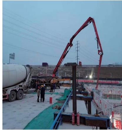
图5.3-2泵送浇筑施工
