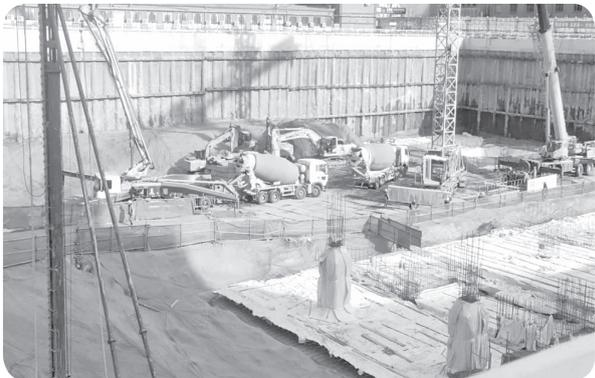
连日来，韩信站迎来了生产小高潮。1月20日以来，接到工地连续浇筑混凝土底板任务，为全力确保顺利供应，提供优质混凝土，韩信站针对项目进行专项部署，各班组紧密协同，高效配合。临近年末，由于部分原材料厂家停产，运输车辆停运，站内技术班组与公司采购管理部快速和供应商联系，确保砂石料按生产计划供应，同时加快原材料进场验收速度，加强源头控制，保障混凝土出厂质量。操作员分秒必争，按照试验最终确定配合比配料、搅拌、放料，手指在操作台上有序拨动。质检员紧盯混凝土出机状态，关注混凝土出机温度，与工地现场人员紧密联系，沟通混凝土情况和施工进度，确保每一车混凝土顺利交付。
