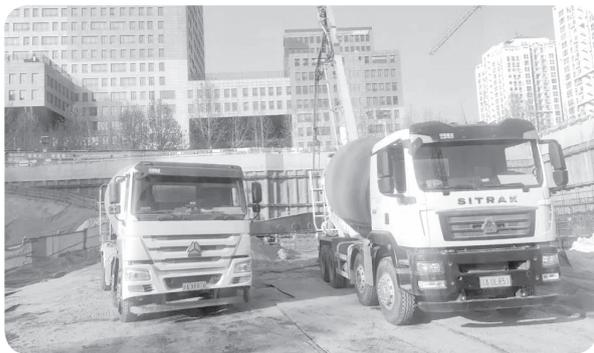
在全员的奋战下，韩信站 24 小时内完成了中关村电子城国际电子总部项目、中关村朝阳园北区、朝阳区太阳宫乡 0301-613 地块等项目的 C35P8 大体积混凝土、C60 高强混凝土、C60 高强加纤维混凝土等多种混凝土的生产供应，实现了日产“开门红”，为完成全年
