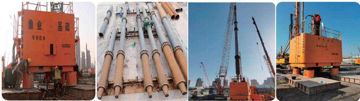
图1 插柱施工工艺
